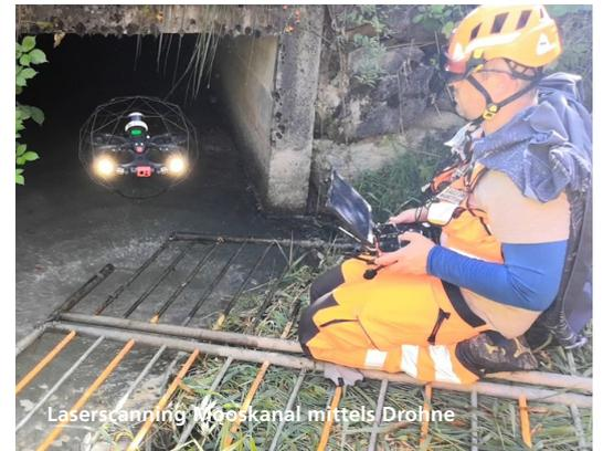
Laserscanning Mooskanal mittels Drohne
